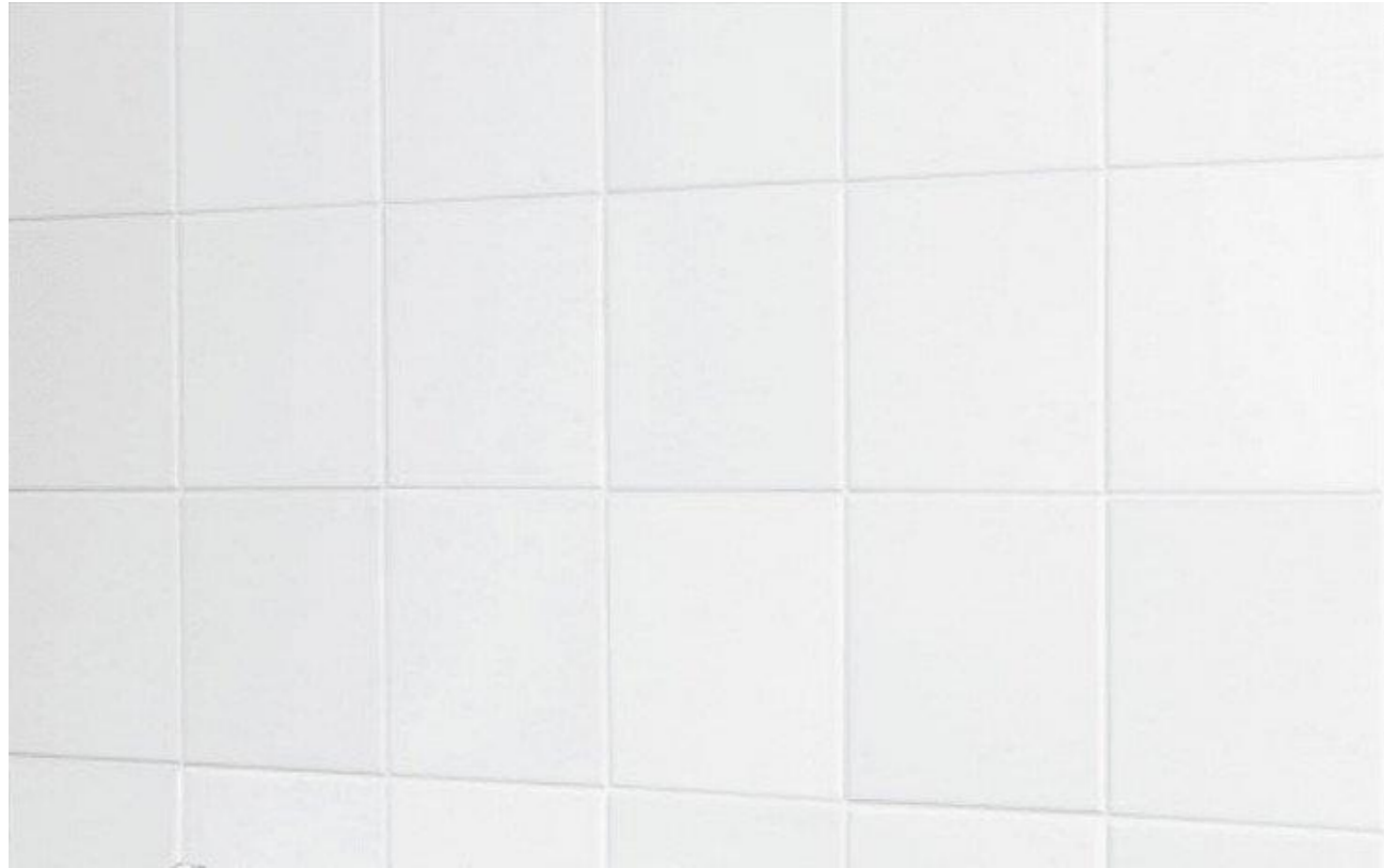
Indervægge overflader: på toiletter opsættes fliser bag håndvaske og tilsvarende udsatte områder. I omklædningsrum opsættes fliser på vægge i badeområde Illustration viser 150X150mm hvide keramiske fliser.
