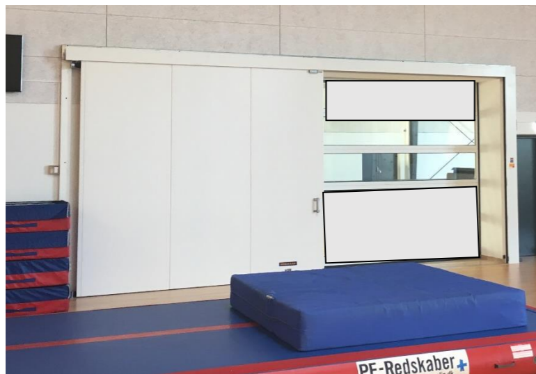
Portblad i hal udføres med kombination af transparente og lukkede højisolerede paneler. (System som Assa Abloy)
